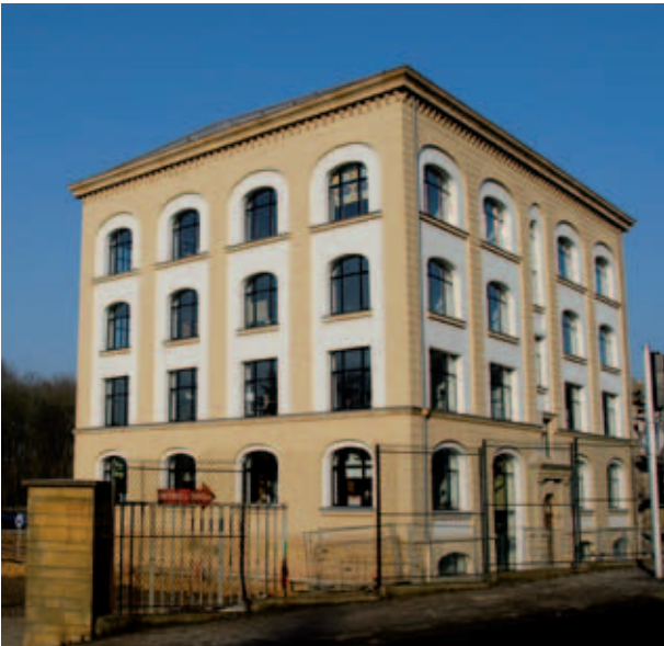
Le Boulevard de Trèves en cours de réhabilitation
