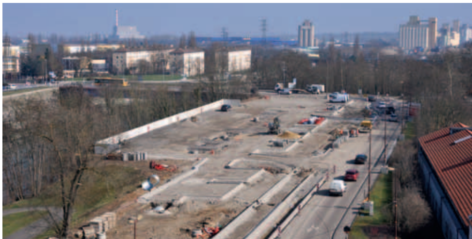
Les travaux du parking provisoire
