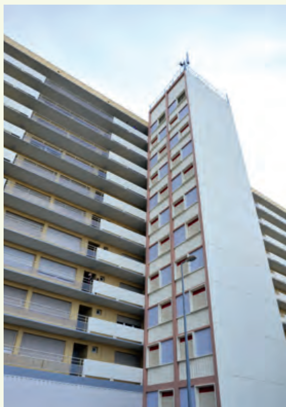
Ci-dessus : une partie des coursives est désormais équipée de garde-corps vitrés.
