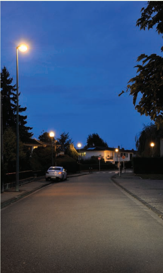
Ci-dessus : de nouveaux luminaires ont été installés rue du Bourdon.
